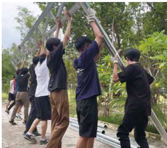
▲臺科大行動工程師團隊在越南邊境小學用輕型鋼材料搭建溫室及屋頂遮陽頂棚。（臺科大提供）
